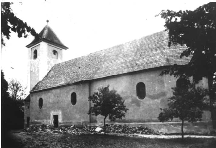
pohled na kostel při započaté demolici tel dokončen již v roce 1929, nemohl
